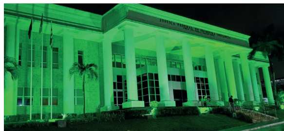
Justiça Federal na Paraíba - Fórum Juiz Federal Ridalvo Costa (edifício-sede da JFP, em João Pessoa)
