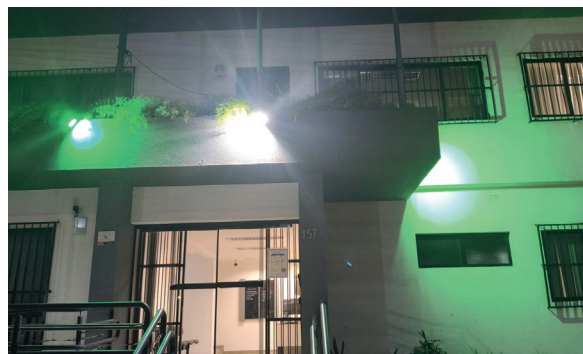
Tribunal Regional Eleitoral de Santa Catarina (TRE-SC) - Prédio Anexo II
