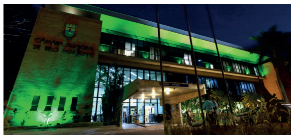
Câmara Municipal de Belo Horizonte - Sede
