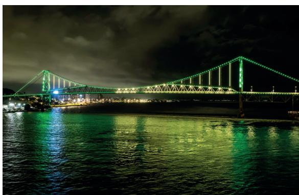
Governo do Estado de Santa Catarina - Ponte Hercílio Luz
