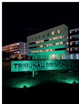
Tribunal Regional Eleitoral do Distrito Federal (TRE-DF) - Edifício-Sede
